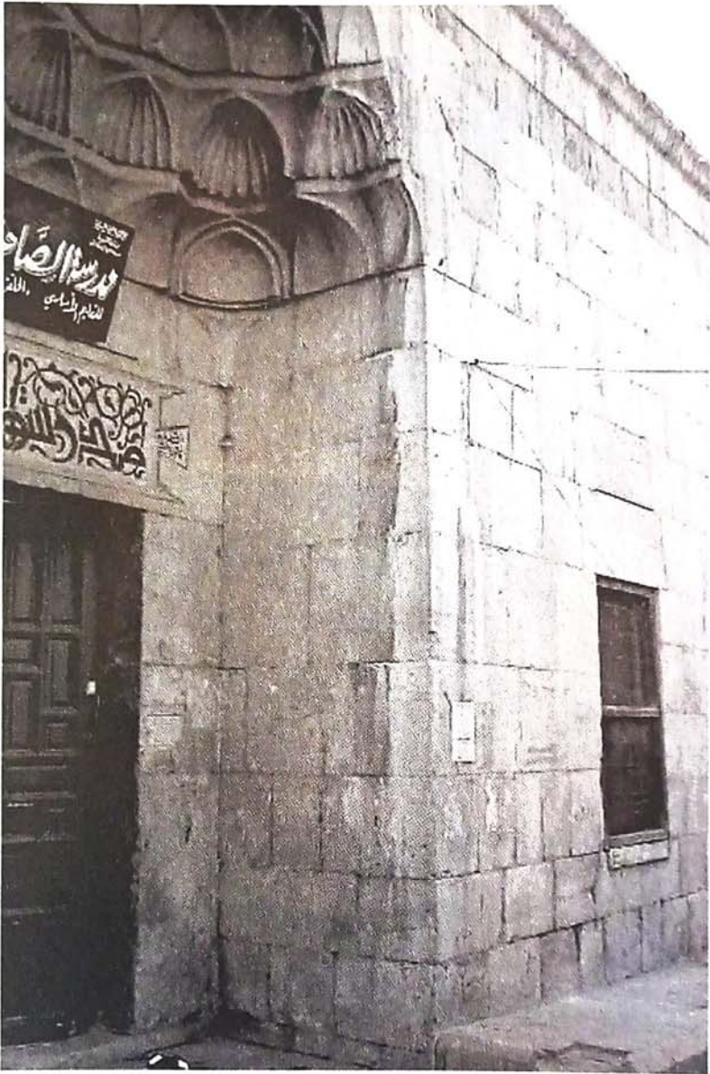
مدرسة الصحابة في الصاحية بدمشق التي بنتها ربيعة خاتون أخت صلاح الدين الأيوبي في 628هـ/1231م، وتشغلها الآن مدرسة ابتدائية لوزارة التربية.
